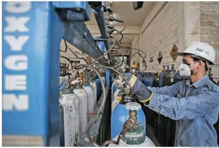
Petugas memeriksa tabung oksigen untuk bantuan penanganan Covid-19 di pabrik gas industri Krakatau Steel, Cilegon, Banten, kemarin. Berhitung sejak 4 Juli 2021 PT Krakatau Steel (Persero) Tbk telah memberikan bantuan pasokan oksigen hingga 3.287 tabung oksigen atau 28,2 ton oksigen.
